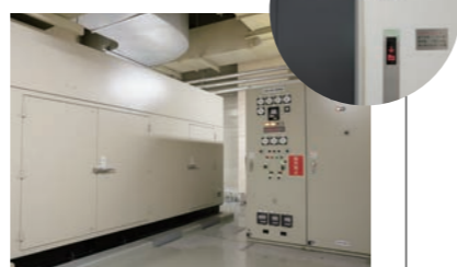
重油で約4時間稼動する非常用発電機を配備
