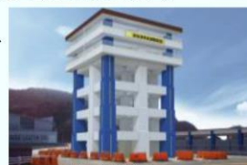
津波避難タワー
