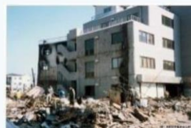
【出典】(一財)消防科学総合センター
