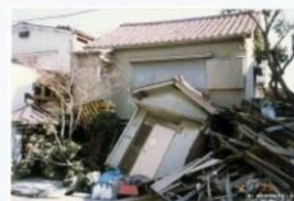
【出典】(一財)消防科学総合センター
