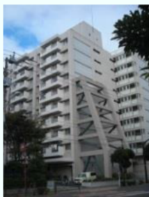
都営住宅の耐震事例
