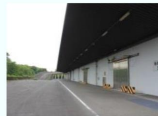
東京都多摩広域防災倉庫
