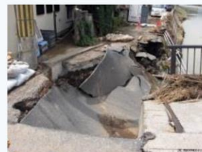
【出典】(一財)消防科学総合センター
