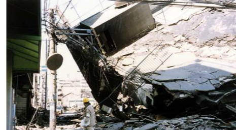
阪神・淡路大震災での被害
