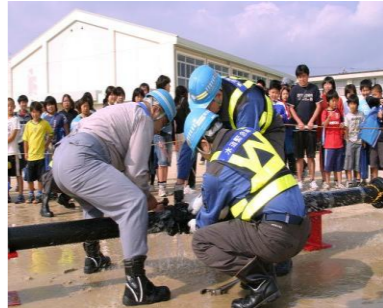
<ライフライン復旧訓練>
