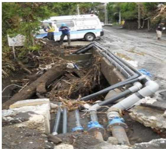
被害状況調査
