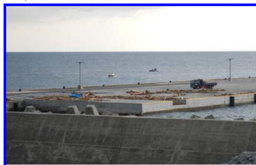
堆積土砂・流木を撤去
