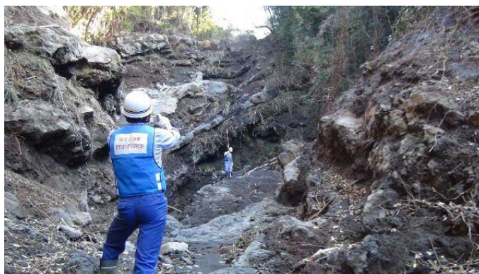
土砂災害危険箇所の緊急点検
