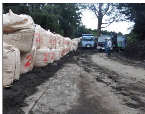
大型土のう設置（神達地区）
