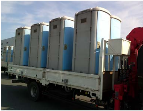
仮設トイレの持込（辰巳ふ頭）
