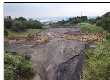
八重沢堆積工
