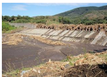
大金沢堆積工
