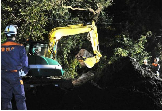
重機を活用した夜間搜索活動
