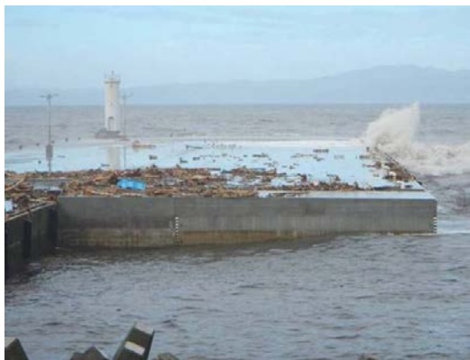
元町港における土砂・流木堆積
