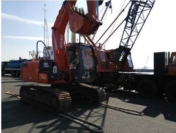
大島に搬送する油圧ショベル（辰巳ふ頭）
