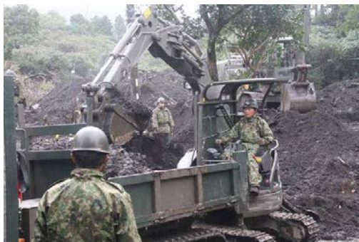
重機による土砂の撤去
