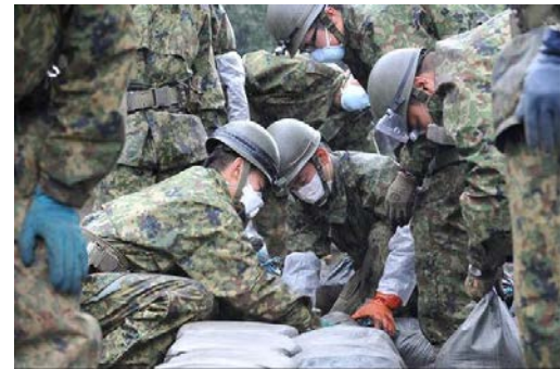
土のう袋の設置
