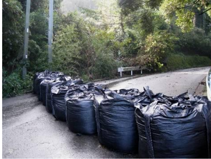
大型土のう設置
