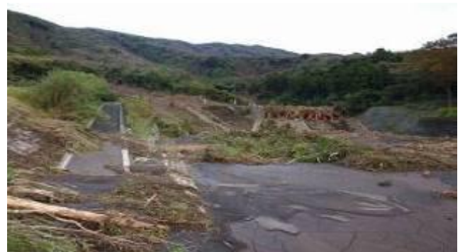
大金沢支川堆積工
