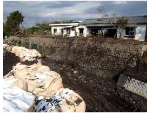
流路崩壊箇所の応急復旧
