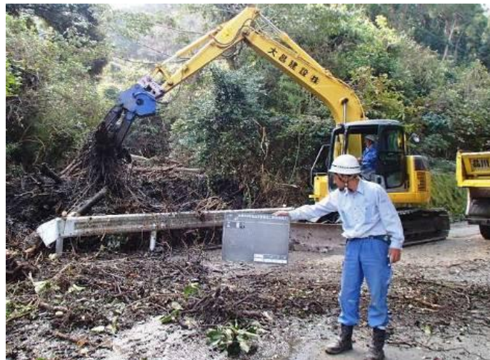
閉窟暗きよの浚渫
