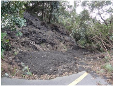
御神火スカイラインへの土砂流入と道路崩落（大島町撮影）
