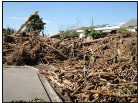
流木等により閉塞された丸塚橋
