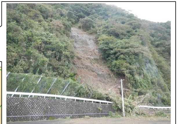
岡田地区における斜面崩壊による道路埋塞
