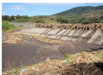
大金沢堆積工
