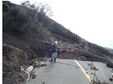
御神火スカイラインへの土砂流入と道路崩落（大島町撮影）
