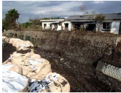
流路崩壊箇所の応急復旧
