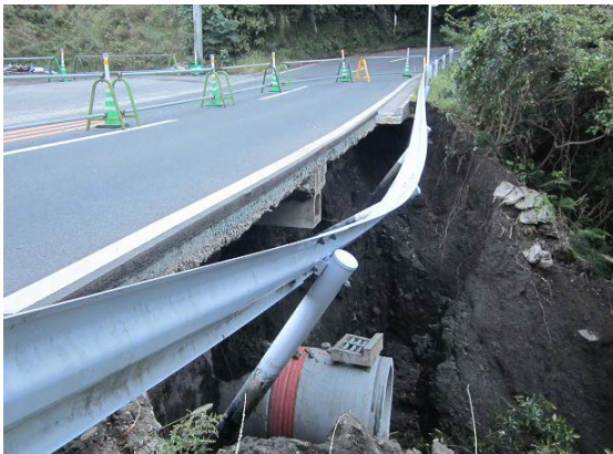
都道大島循環線（野増地区）の被災状況と応急仮復旧状況
