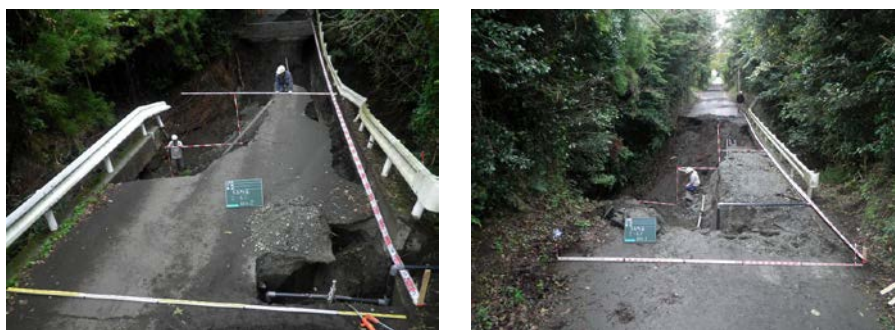
泉津地区の町道の被災状況（大島町撮影）
