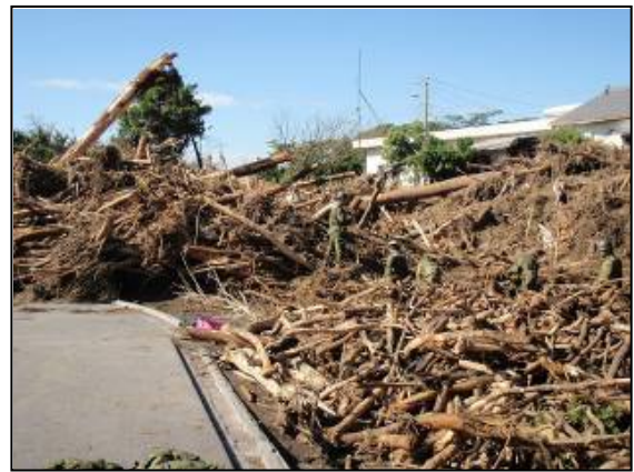
流木等により閉塞された丸塚橋
