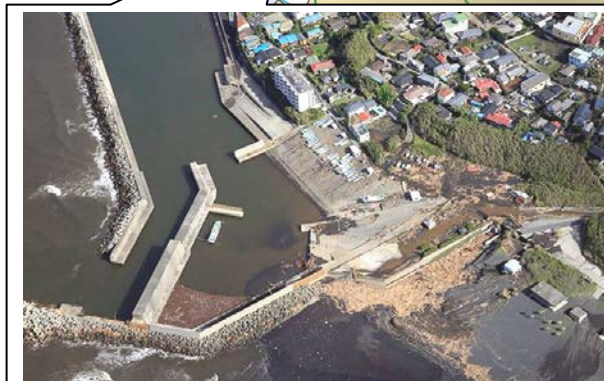
元町地区における土石流による土砂・流木堆積 (株式会社パスコ撮影)
