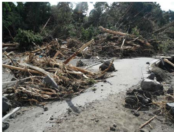
道路に流入し、氾濫、堆積した土砂や流木
