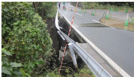
都道の被害状況
