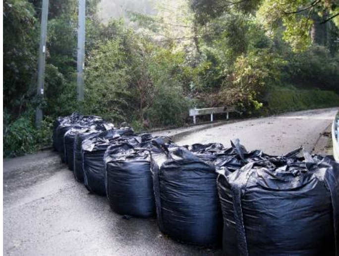
大型土のう設置
