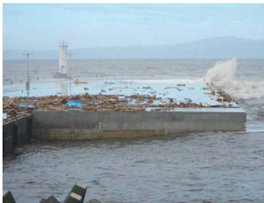
元町港における土砂・流木堆積
