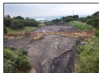
八重沢堆積工
