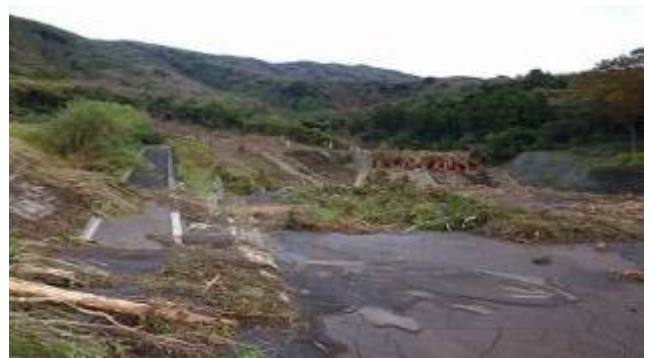
大金沢支川堆積工
