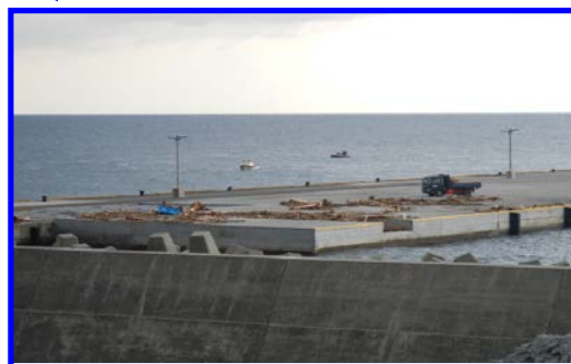
堆積土砂・流木を撤去
