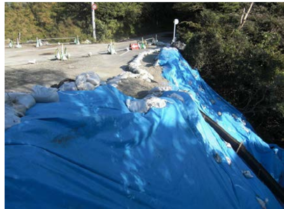
都道大島循環線（野増地区）の被災状況と応急仮復旧状況
