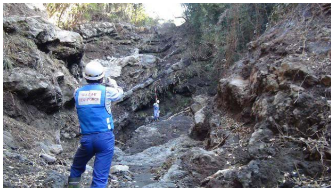
土砂災害危険箇所の緊急点検
