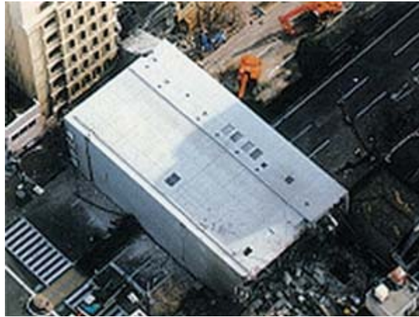
阪神・淡路大震災で倒壊したビル 出展:国土交通省資料
