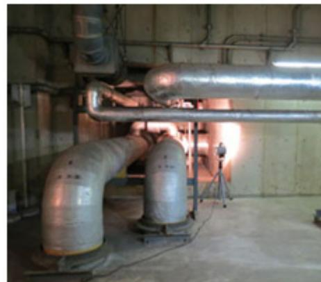
写真：送電線・冷温水管受入口
