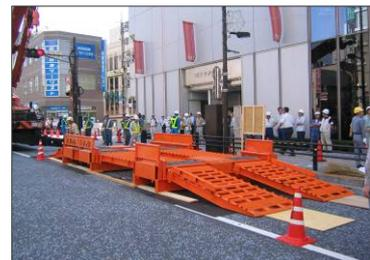
[段差解消のための仮橋設置]
