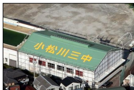
体育館屋根設置例
