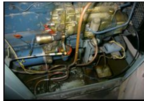
自家発電設備内部の劣化
