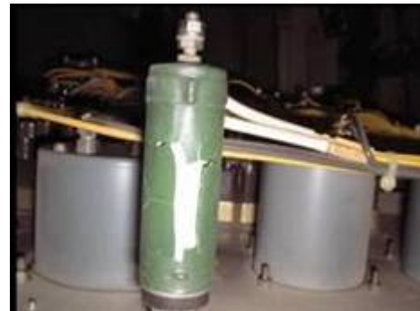
受配電盤内の劣化
