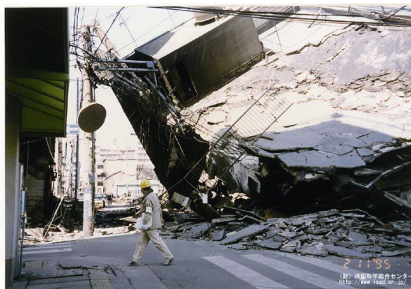
阪神・淡路大震災で倒壊したビル
