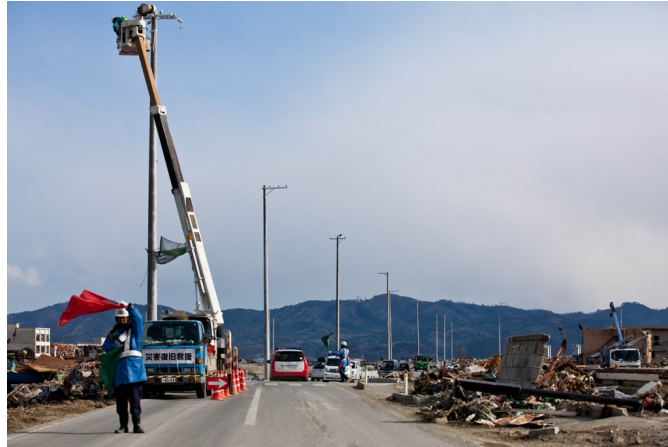
被災地における電柱の復旧作業
