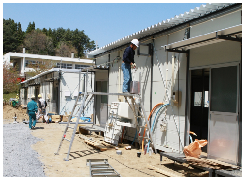
被災地での応急仮設住宅の建設
