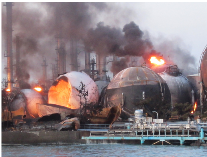
東日本大震災におけるタンク火災（千葉県市原市）
