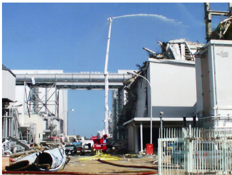
ハイパーレスキュー隊による放水活動（福島第一原子力発電所）
