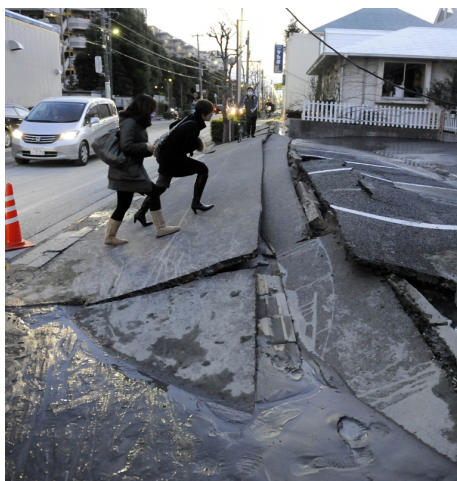
東日本大震災による液状化被害（千葉県浦安市）
