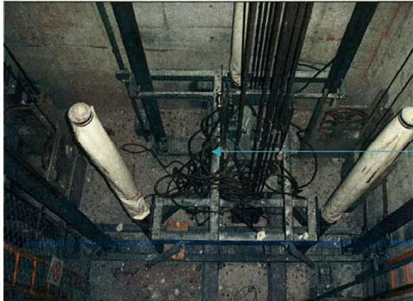
写真4 新宿西口超高層ビルのエレベータ被害例
