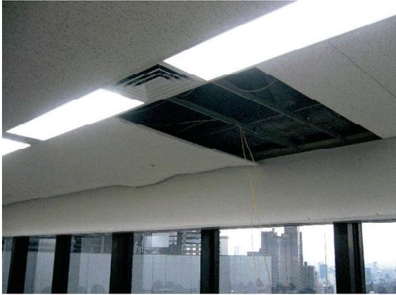
写真1 天井パネルの落下(28階)
