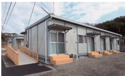
スロープを配し、バリアフリーに配慮
