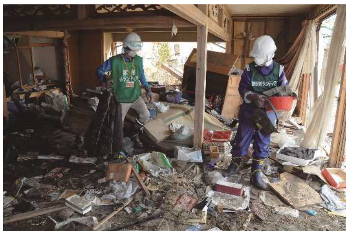
東日本大震災被災地に派遣された都民ボランティア
