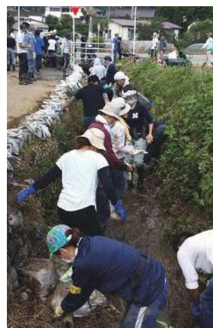
平成27年9月関東・東北豪雨の水害復興ボランティア (写真提供:NPO法人 Power of JAPAN)
