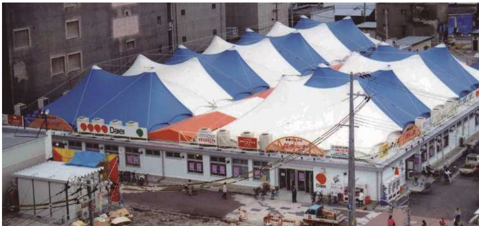
仮設商店街「復興げんき村パラール」(写真提供：神戸市)
