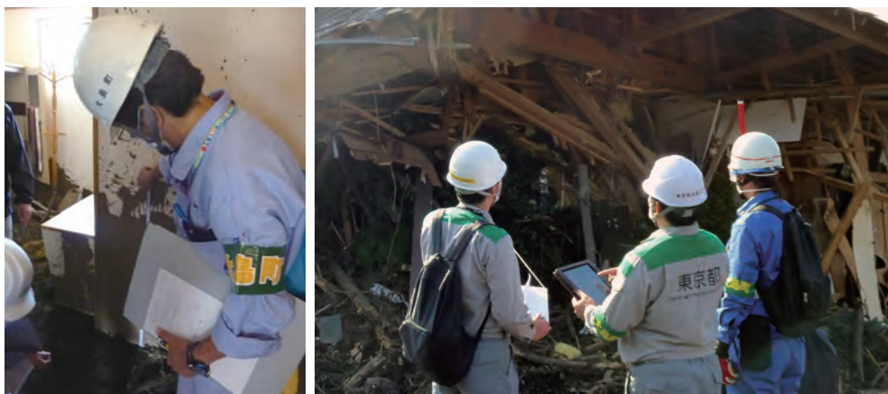
大島町での家屋被害状況調査（平成 25 年）
