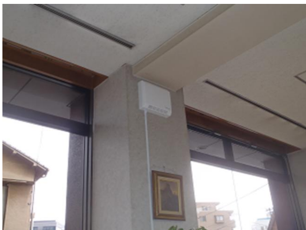
（都立一時滞在施設に設置された Wi-Fi アクセスポイント）
