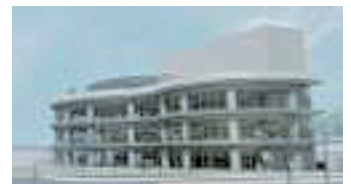
津波避難施設
