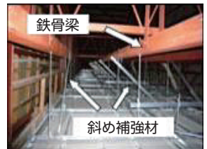
金属下地天井への改修
