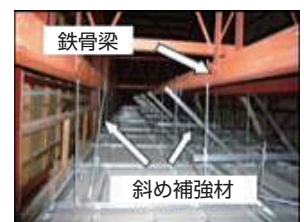
金属下地天井への改修
