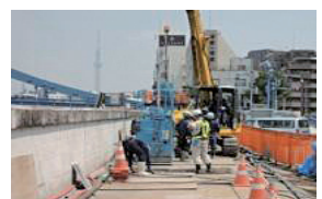
防潮堤の耐震化
