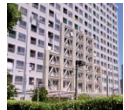
集合住宅の耐震改修事例
