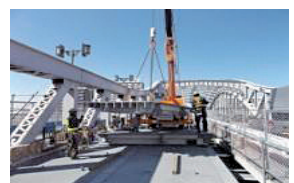
橋梁の長寿命化工事
