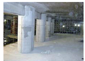
耐震補強後（浄水施設）
