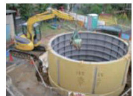
防火水槽の設置状況
