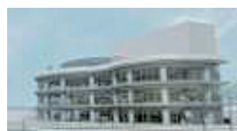
津波避難施設
