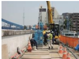
(防潮堤の耐震化)
