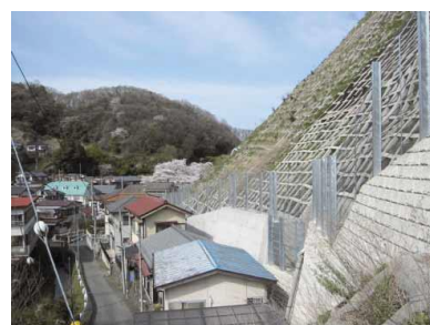
急傾斜地の土砂災害対策例
