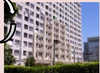
(集合住宅の耐震改修事例)
