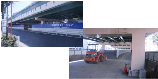
高架下を活用した道路防災ステーション
