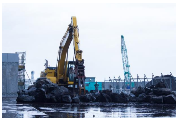
障害物除去訓練
