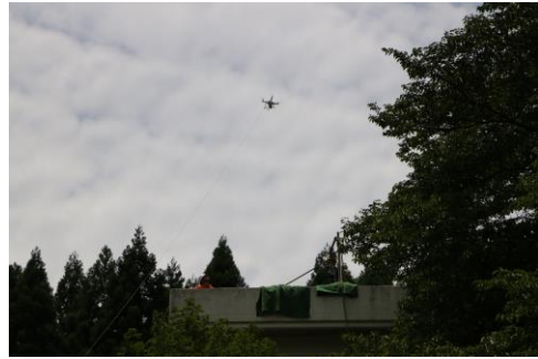
ドローンによるロープ搬送
