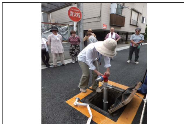
スタンドパイプ取付け
