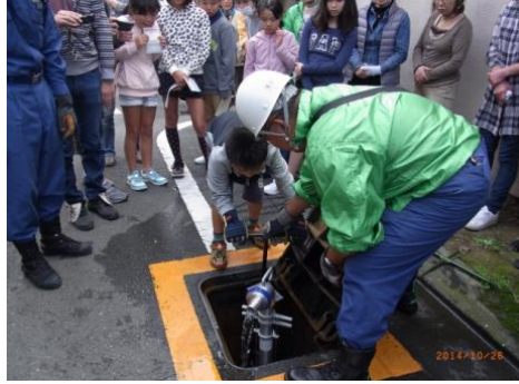
⑭消火栓にスタンドパイプをセット
