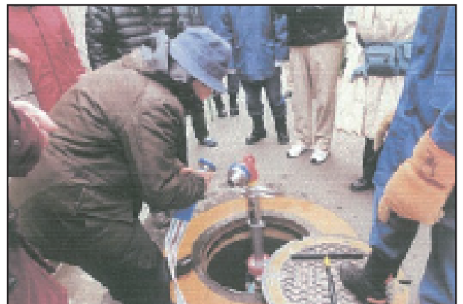
スタンドパイプ取付け
