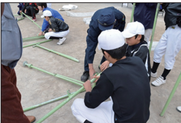
仮設トイレの組立て
