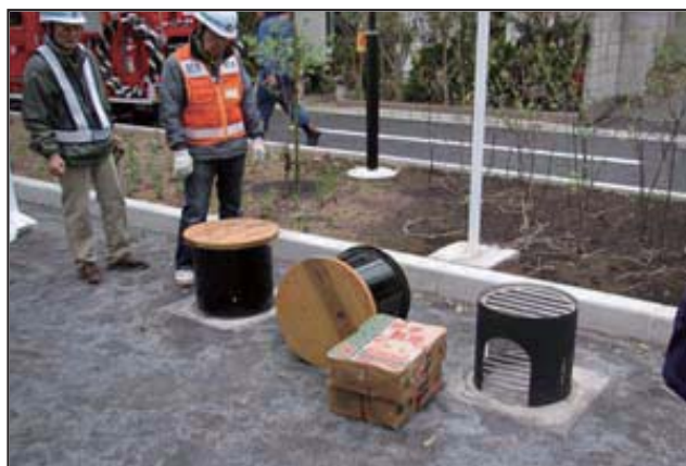
公園の防災設備
