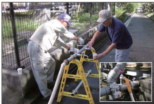
受水槽からの応急給水
