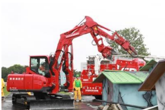
双腕重機による障害物除去活動
