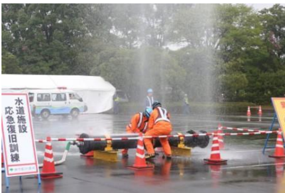
水道施設の応急復旧実演
