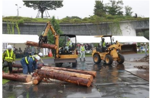
東京都建設局による障害物除去訓練
