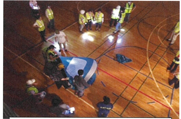
多目的ハウスの設置
