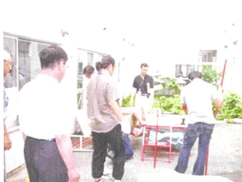
【仮設トイレを組み立てます】
