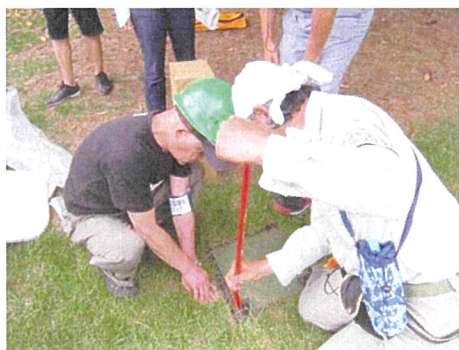
【校庭にマンホールトイレを設置します】
