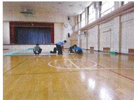
【滑らないように養生テープで固定します】
