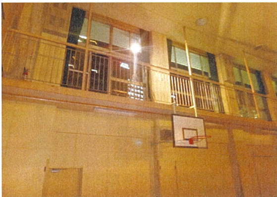
【体育館ギャラリー一部に発電機と投光器を設置しました】
