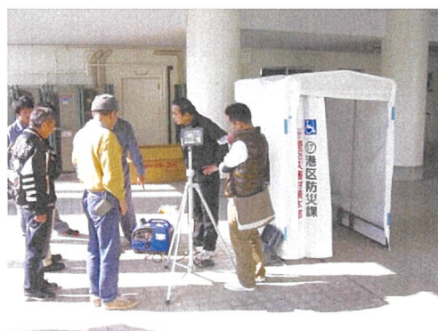
【投光機と仮設トイレを設置します】
