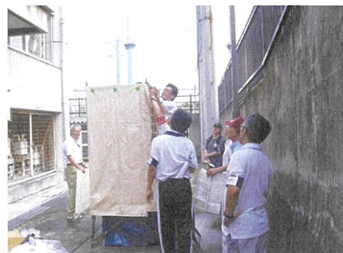
【災害時におけるトイレは非常に重要です】
