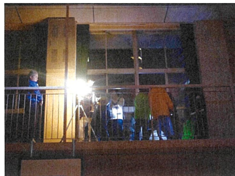
【体育館ギャラリー部に発電機と投光器を設置】
