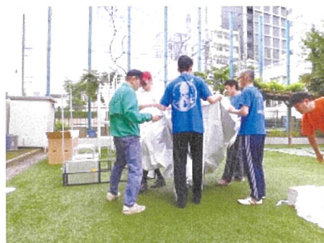
【校庭の通用口横に仮設トイレを設置します】
