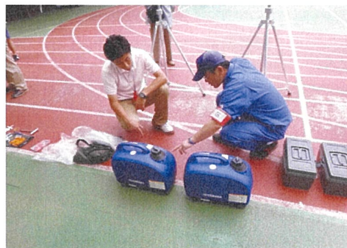
【発電機を用いて照明を確保します】
