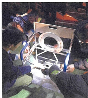
【マンホールトイレ組立の様子】
