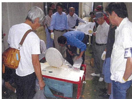
【地下1階非常用通路にトイレを設置します】
