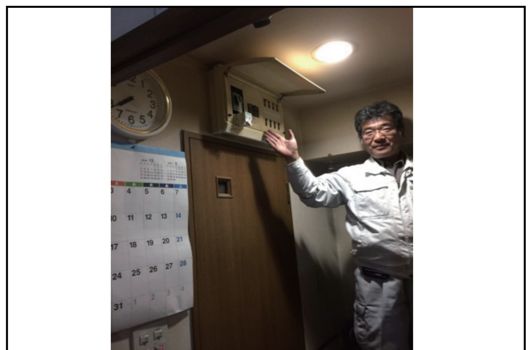
感震ブレーカー設置
