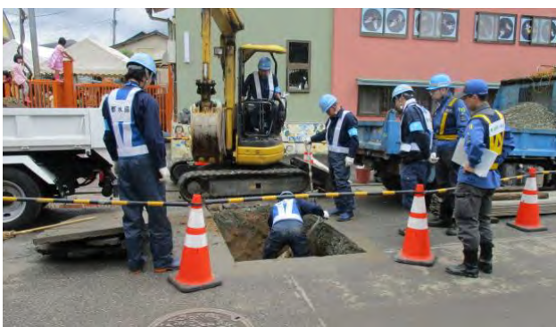
【参考】熊本市漏水補修工事の様子
