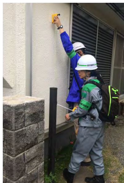
【参考】被災自治体における 被災建築物応急危険度判定の様子②
