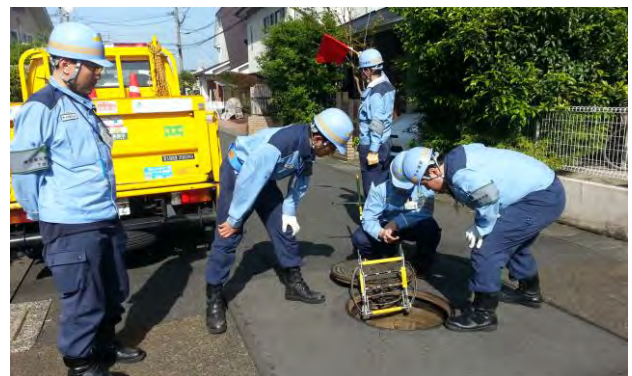
【参考】下水道管の被害調査の様子
