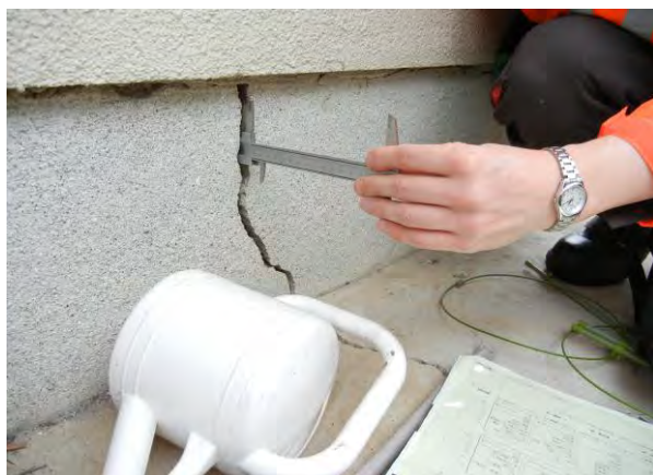
【参考】被災自治体における 被災建築物応急危険度判定の様子①
