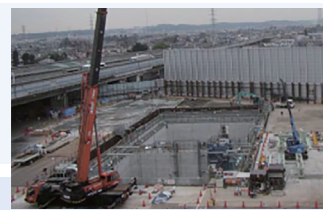
外環道 東名 JCT トンネル立坑部
