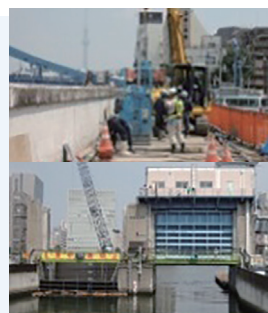
堤防・水門の耐震強化
