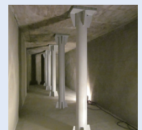
経年防火水槽再生工事
