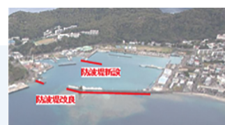
津波に対する防波堤改良・新設
