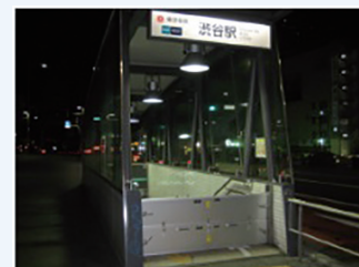
止水板設置事例
