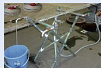
消火栓等を活用した応急給水
