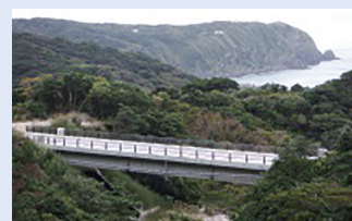
島しょ部の道路整備（神津島） 一般都道長浜多幸線（天上橋）
