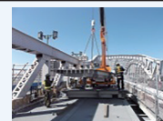
橋梁の予防保全型管理
