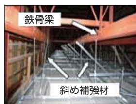
金属下地天井への改修
