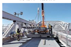
橋梁の長寿命化工事
