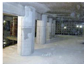
耐震補強後（浄水施設）
