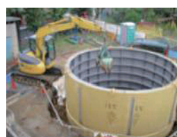
防火水槽の設置状況
