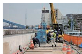
防潮堤の耐震化
