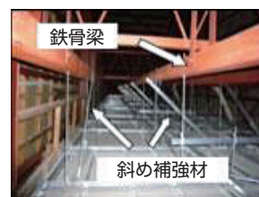
金属地下天井への改修
