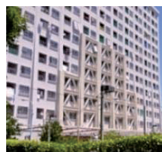
集合住宅の耐震改修事例
