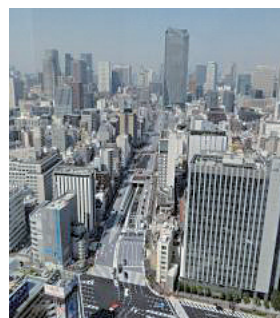
区部環状道路 環状 2 号線（新橋～虎ノ門区間）
