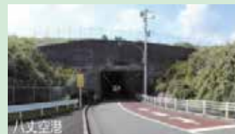
空港土木施設
