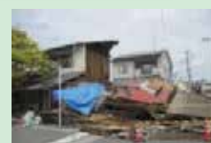
熊本地震での木造住宅の被害
