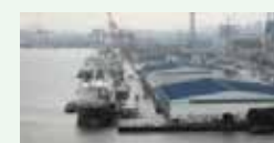
ふ頭（耐震強化岸壁）
