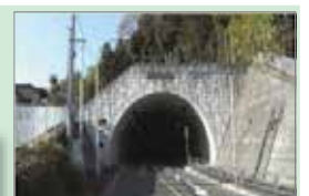
山岳トンネル
