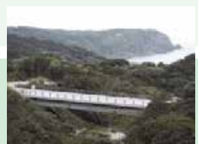
島しょ部の道路整備（神津島）
