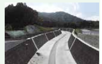
大金沢下流導流堤
