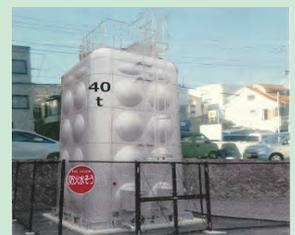
地上置縦型防火水槽の設置イメージ
