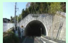
山岳トンネル
