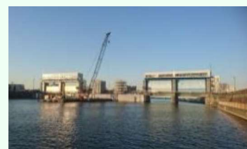
水門耐震対策工事（今井水門）
