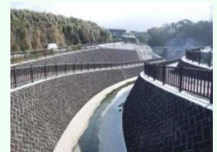
大金沢流路工
