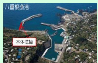
八重根漁港での防波堤改良
