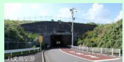
空港土木施設
