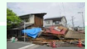
熊本地震での木造住宅の被害
