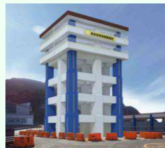
新島港津波避難施設 （津波避難タワー）
