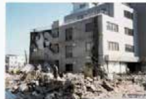
【出典】(一財)消防科学総合センター
