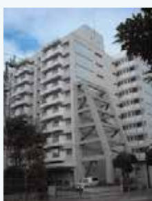
都営住宅の耐震事例
