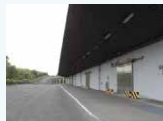
東京都多摩広域防災倉庫
