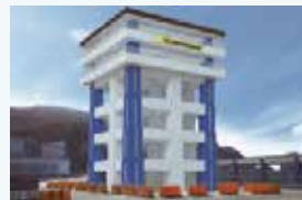
津波避難タワー
