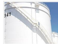
危険物タンク外観 (三菱石油(株)HPより引用)
