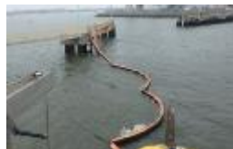
海上災害時の応急措置の例 (オイルフェンスの展張)
