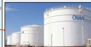
既設タンク(10基)
