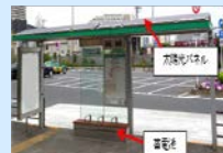
バス停留所に設置された太陽光発電設備
