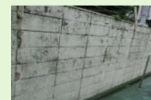
対策が必要なブロック塀
