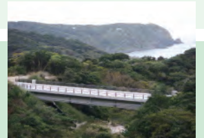
島しょ部の道路整備（神津島）
