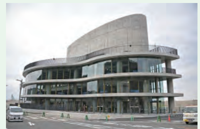
岡田港津波避難施設（津波避難タワー）
