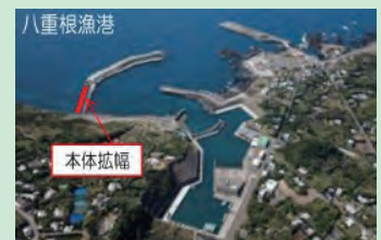
八重根漁港での粘り強い構造への転換
