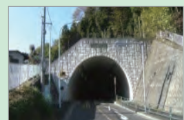
山岳トンネル
