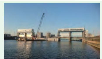
水門耐震対策工事（今井水門）
