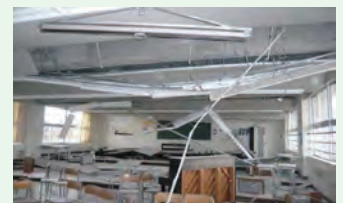
非構造部材落下事例
