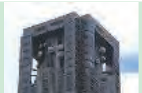
防災行政無線アンテナ
