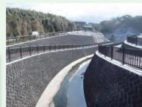
大金沢流路工
