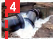
浄水場の耐震化
