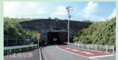
空港土木施設
