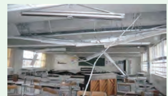
非構造部材落下事例
