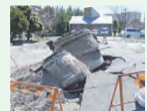
液状化によるマンホールの浮上
