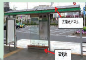
バス停留所に設置された太陽光発電設備（南千住駅）
