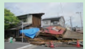
熊本地震での木造住宅の被害
