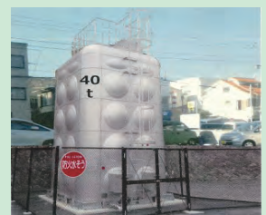
地上置縦型防火水槽の設置イメージ
