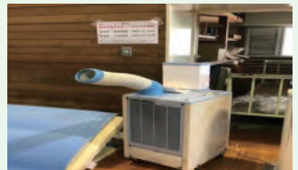
平成30年7月豪雨時の避難所で設置された冷房
