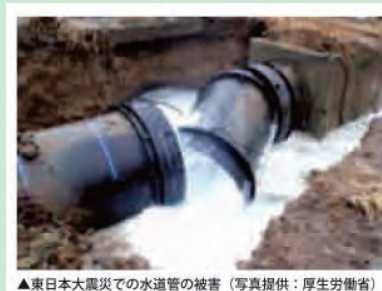
▲東日本大震災での水道管の被害（写真提供：厚生労働省）
